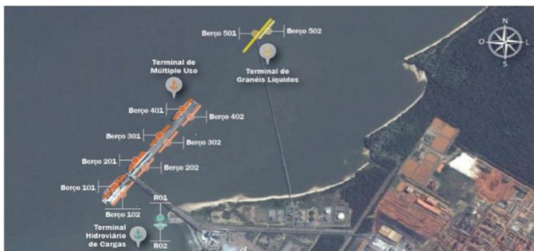
Figura 2 – Infraestrutura de acostagem do Porto de Vila do Conde Fonte: Plano Mestre LabTrans/UFSC (2017).
